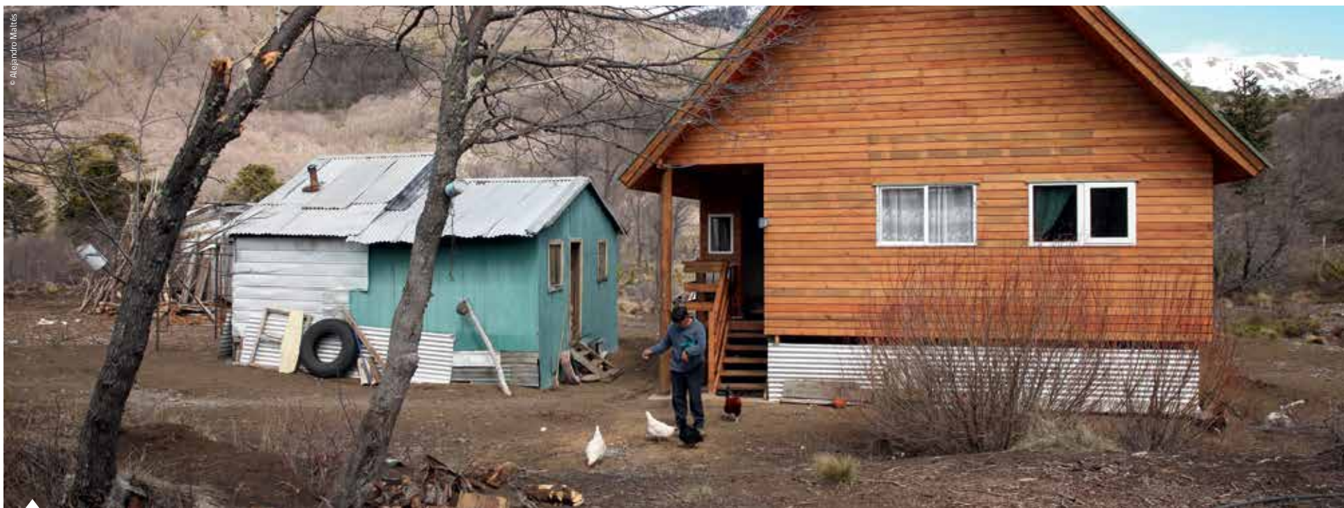
El Minvu desarrolló viviendas para soportar las nevazones de la zona cordillerana de La Araucanía. Tienen techos por los que escurre fácilmente la nieve y aislación térmica con ventanales de PVC. Manuel Meliñir es uno de los beneficiarios. En la imagen, a la derecha, su casa nueva; a la izquierda, su antigua vivienda.
