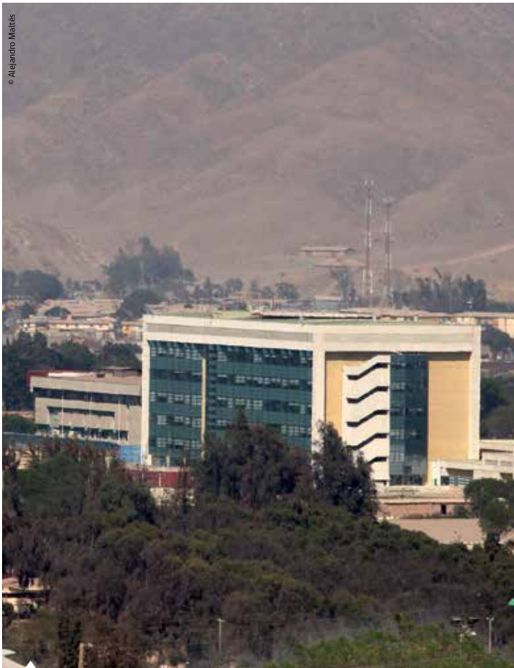
Nuevo Hospital de Copiapó, en la Región de Atacama.
