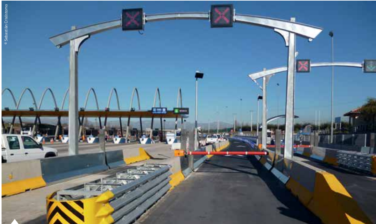
Para mejorar los accesos a Santiago se implementó un sistema electrónico de cobro de peajes en las rutas 5 Sur y 68. En la imagen, los pórticos de esta última disponibles desde junio de 2012.
