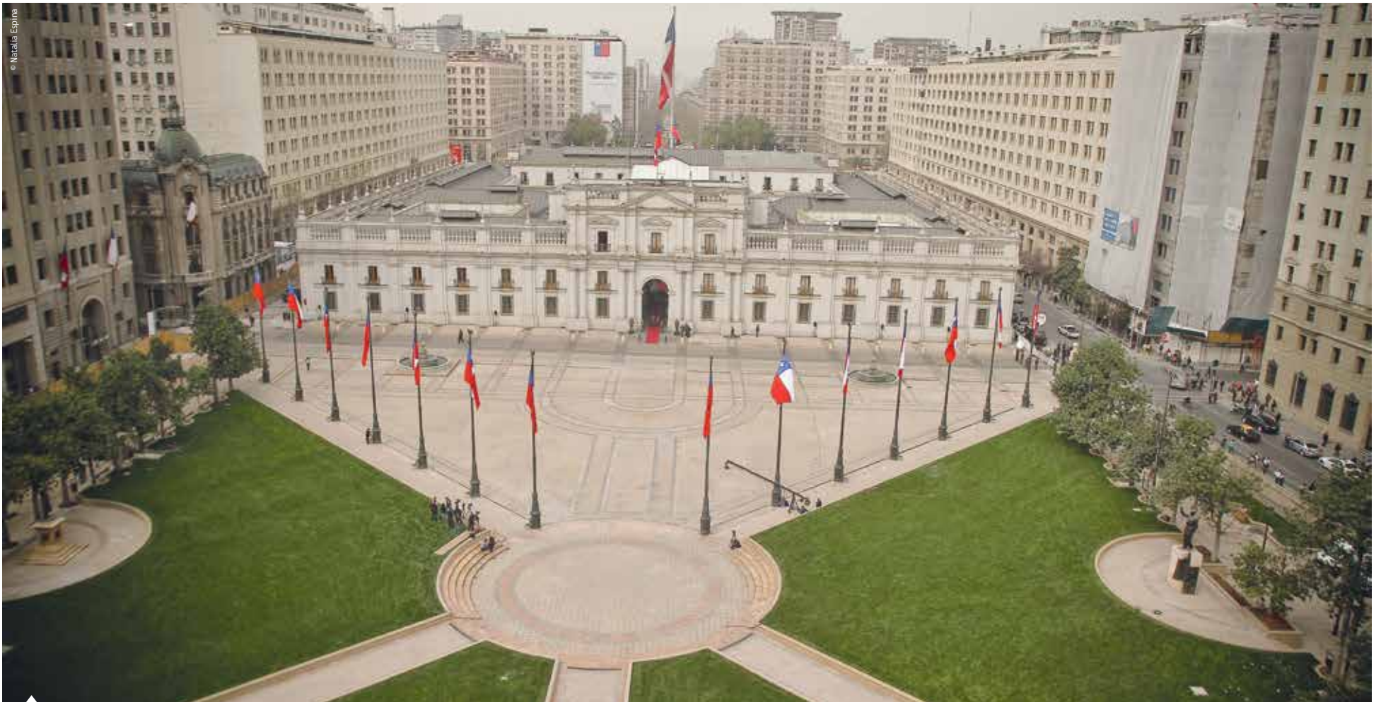
Los trabajos estuvieron orientados a terminar con las filtraciones producidas por las jardineras, limpiar los monumentos y obeliscos y a recuperar el mobiliario, entre otros.
