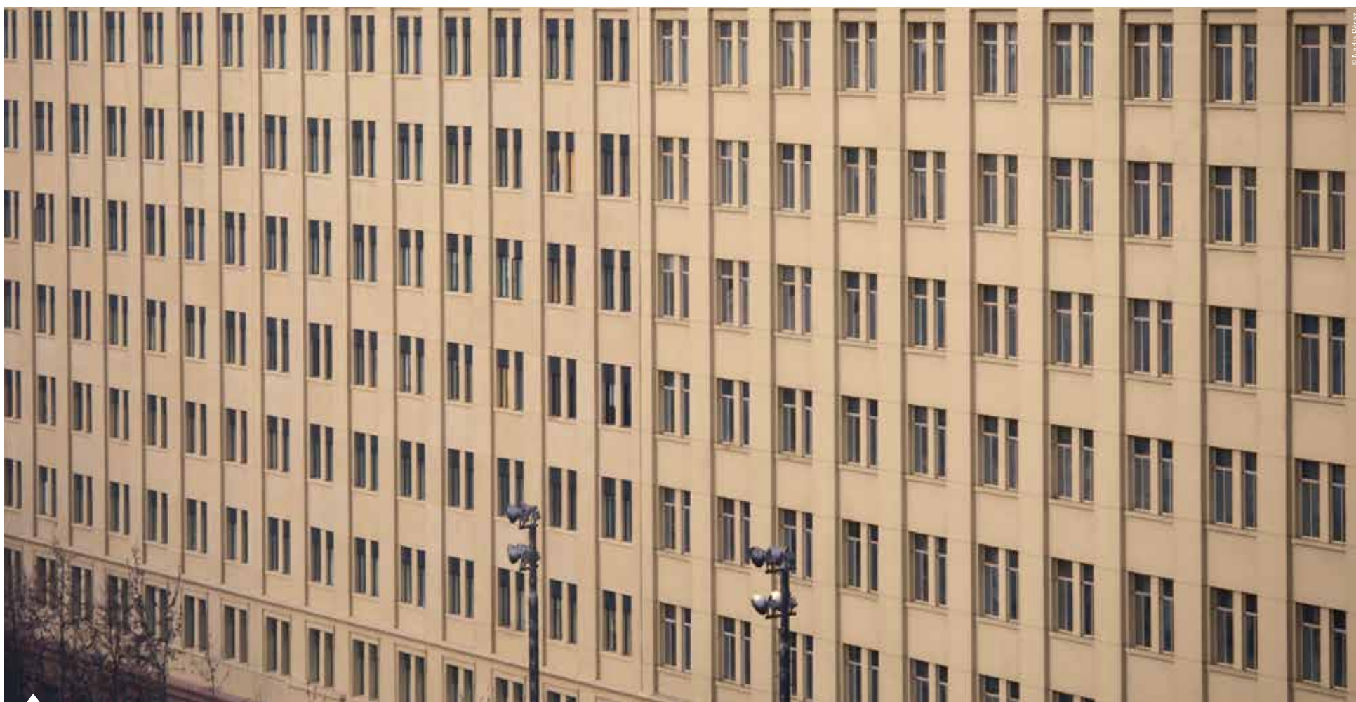
Las fachadas de los edificios estaban muy deterioradas. Con la restauración están recuperando su color, textura y solidez original de los años 30.
