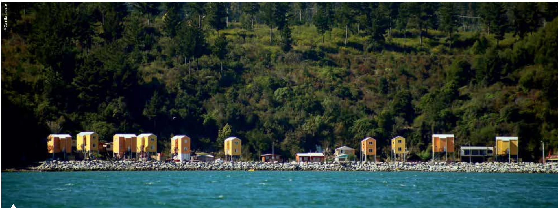
El plan de reconstrucción de Dichato consideró el desarrollo de viviendas palafito, tsunami resistentes. En la imagen, los conjuntos de Caleta Villarrica.
