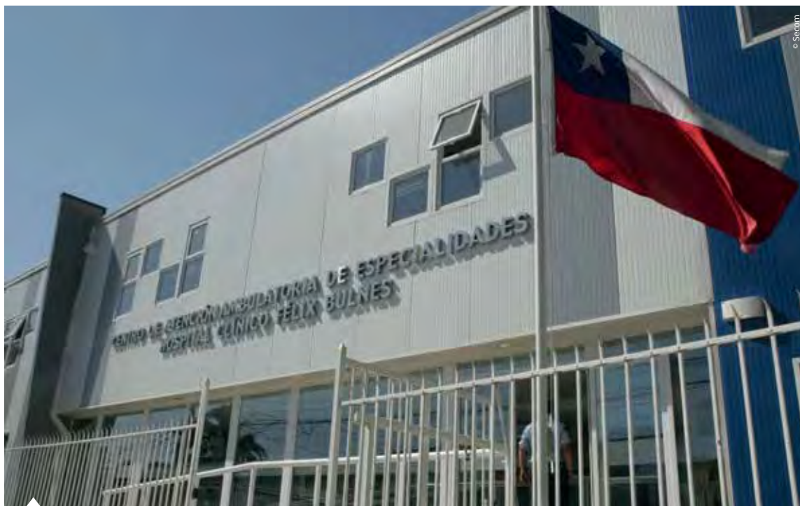
El Hospital Clínico Félix Bulnes, Región Metropolitana, resultó seriamente dañado. En junio de 2011 se inauguró el nuevo Centro de Atención Ambulatoria de Especialidades del recinto de salud, que beneficia a más de 600 mil personas.
