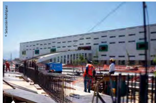
El Hospital Regional de Rancagua, en plena construcción.
