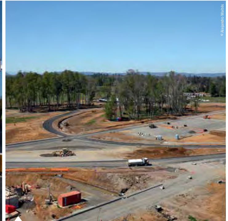
Con la inauguración del nuevo aeropuerto de La Araucanía en 2014, el país contará con 189 mil 820 m 2 de terminales aéreas. En la foto, las obras del mencionado aeropuerto, en octubre de 2013.
