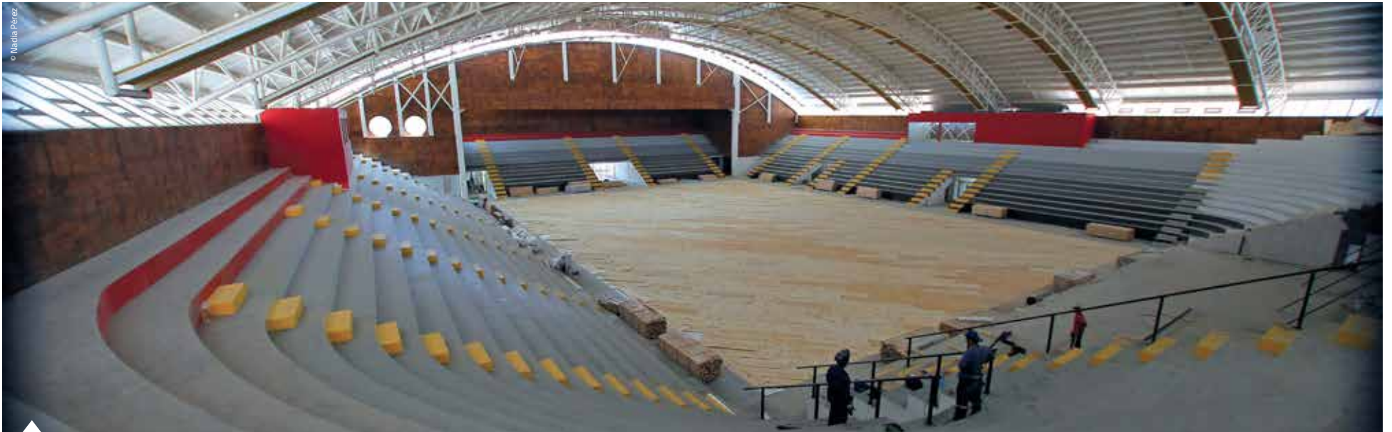
La multicancha principal del Polideportivo de Los Ángeles, en la Región del Biobío, tiene una capacidad para cuatro mil 600 espectadores. La primera etapa de construcción del recinto terminó a mediados de 2013.
