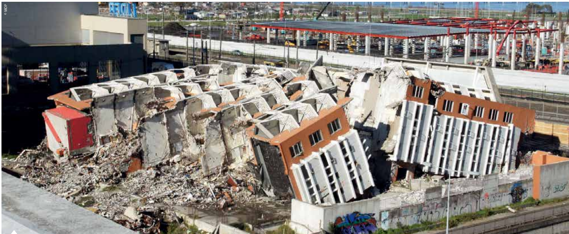
Vista panorámica del edificio Alto Río, en Concepción, que colapsó la madrugada del 27 de febrero.
