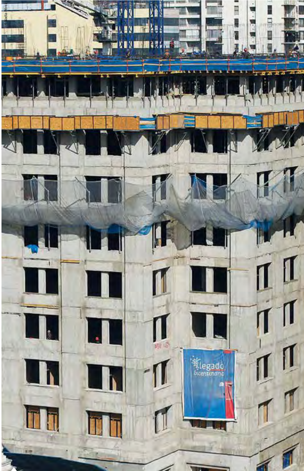
Con 39 mil metros cuadrados de superficie, el edificio albergará las dependencias de los ministerios del Interior y Seguridad Pública, Secretaría General de Gobierno y Secretaría General de la Presidencia, entre otros.
