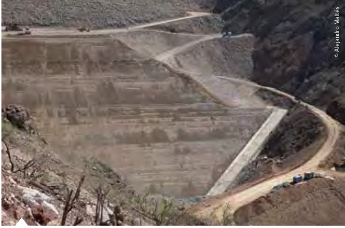
19.08.2013 | Obras de construcción del embalse Chacrillas, en la Región de Valparaíso.
