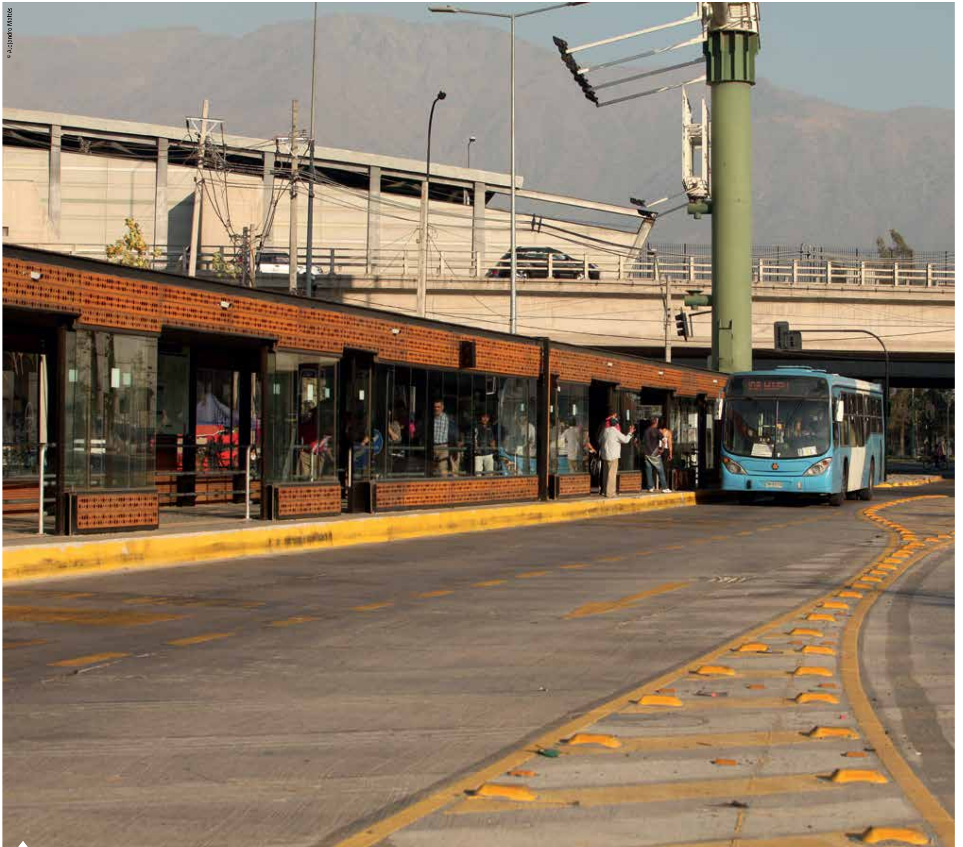
Otra de las iniciativas para mejorar la calidad del sistema fue la inversión para aumentar la cantidad de paraderos. En la foto, el construido en Avenida La Florida con Departamental.
