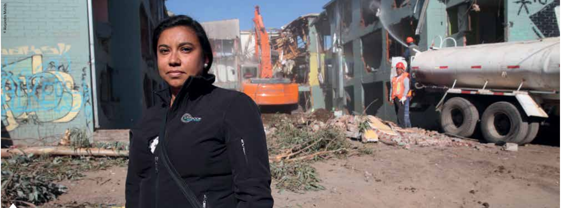
30.08.2013 | Pamela Labbé, residente por 16 años de la población Francisco Coloane, en el sector Bajos de Mena, en Puente Alto, observa el inicio de los trabajos de demolición de este emblemático conjunto. Gracias al programa Segunda Oportunidad del Minvu podrá acceder a una nueva vivienda social.
