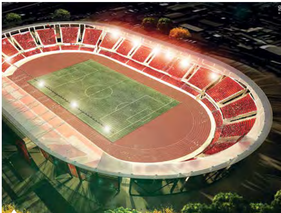
El mal estado y los sismos hicieron inviable la reparación del Estadio La Portada de La Serena. Por ello, el gobierno se hizo cargo de su reconstrucción. Aquí una imagen de su diseño.
