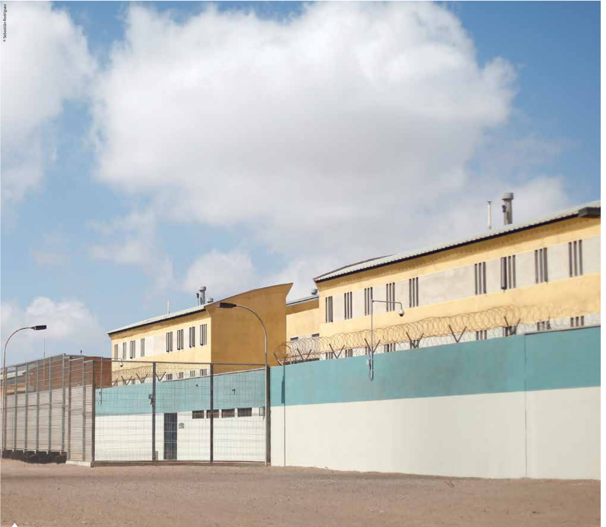
La nueva cárcel de Antofagasta, inaugurada en agosto de 2013, cuenta con una superficie total de 37 mil metros cuadrados e instalaciones para mil 160 reclusos.
