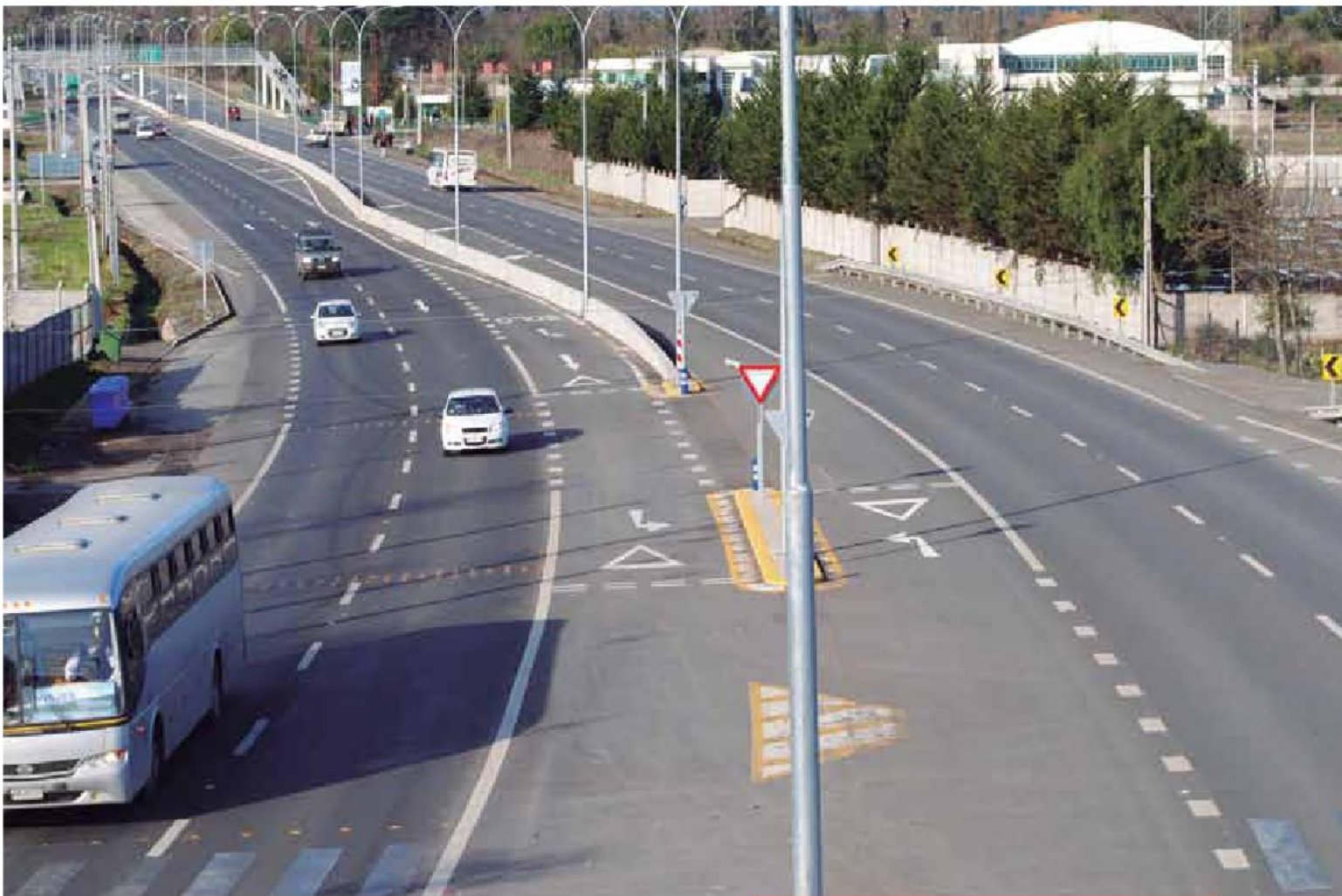
Ampliación a doble vía de la Ruta S-30, en el tramo Temuco-Labranza.
