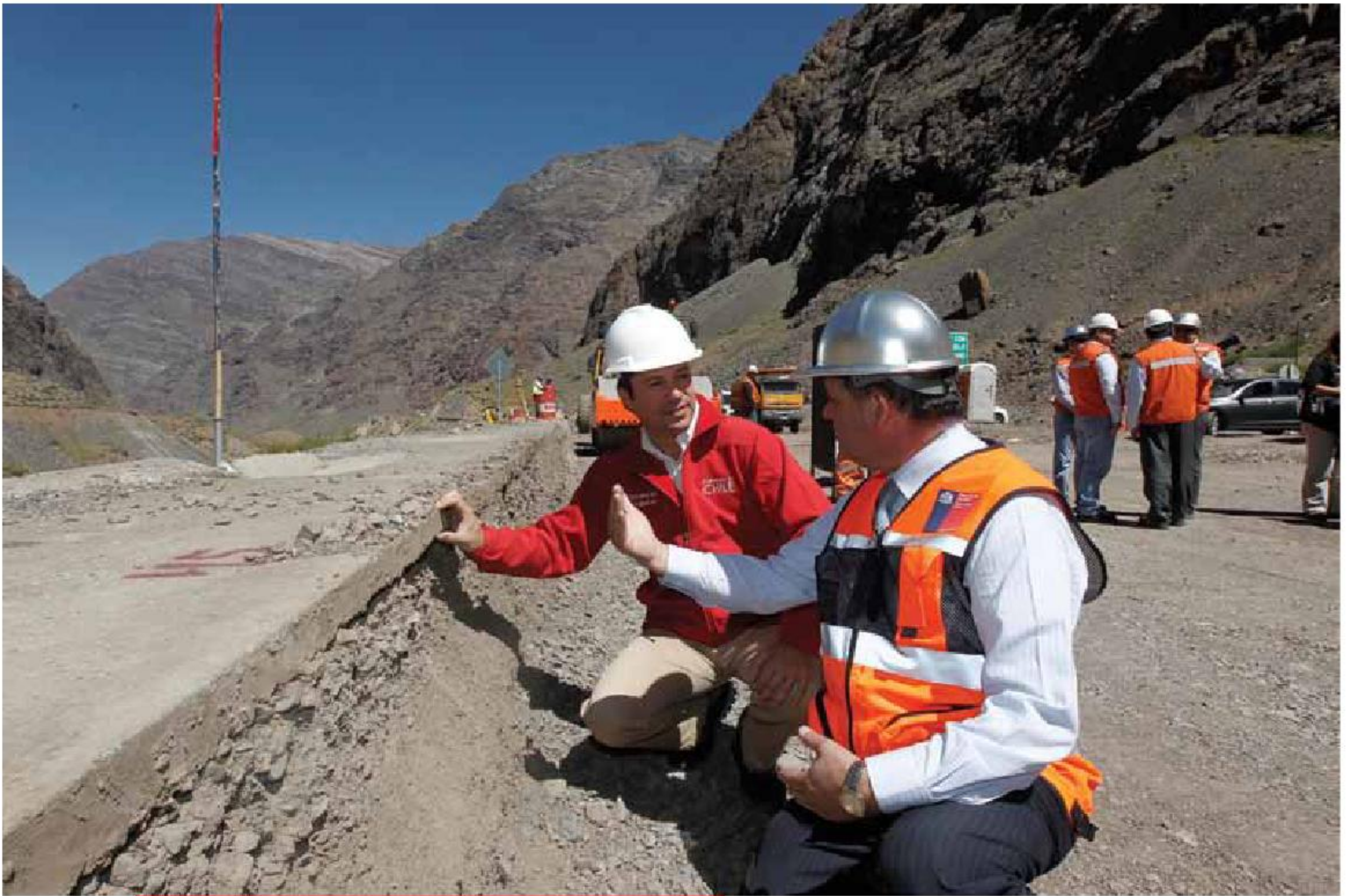
El subsecretario de Obras Públicas, Lucas Palacios, inspecciona las obras en la Cuesta Caracoles de la Ruta 60 CH. 8 de enero de 2013.
