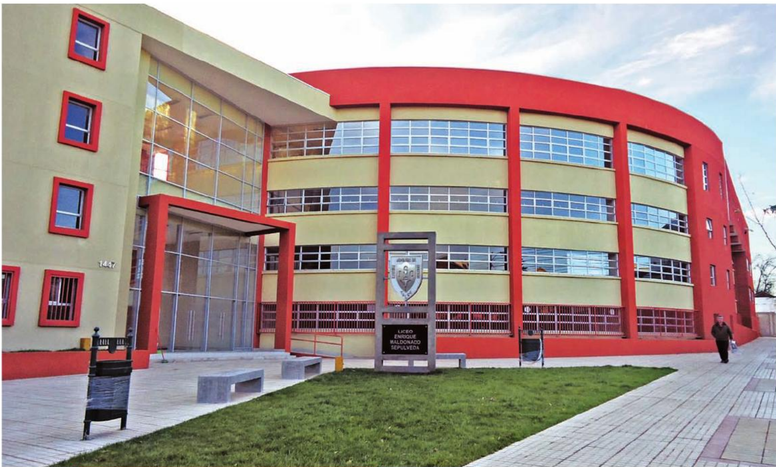
Frontis de las nuevas instalaciones del Instituto Superior de Comercio Enrique Maldonado de Talca. Las obras fueron terminadas en junio de 2013.
