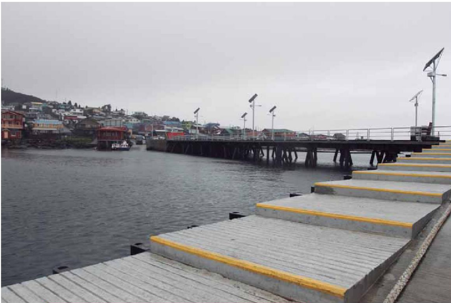
Nuevas instalaciones del Muelle Multipropósito de Melinka, que comprenden un terminal portuario, explanada de acceso, puente de acceso con acera peatonal y calzada vehicular.
