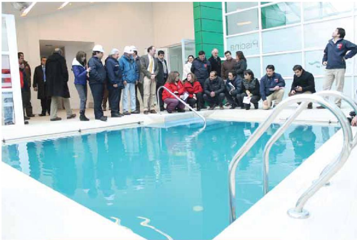
El Gabinete Regional de Aysén comprobó en terreno el actual estado de las obras civiles del Centro Teletón en Coyhaique.
