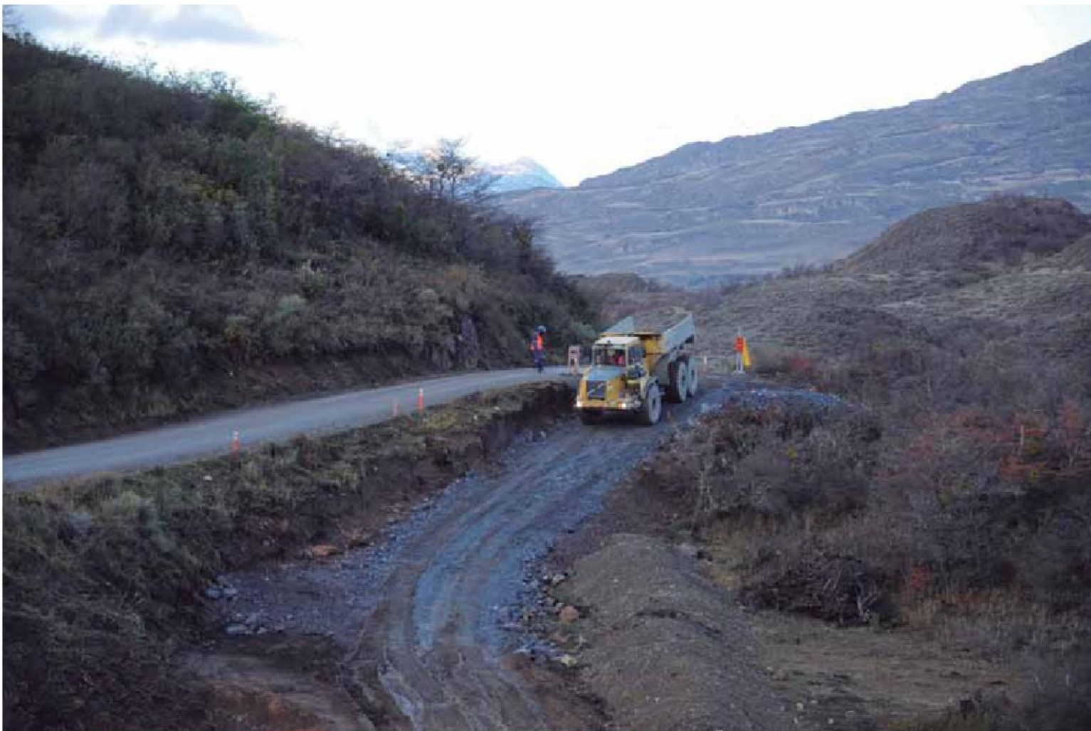
Obras de mejoramiento de la cuesta Las Eses en la Carretera Austral Sur.
