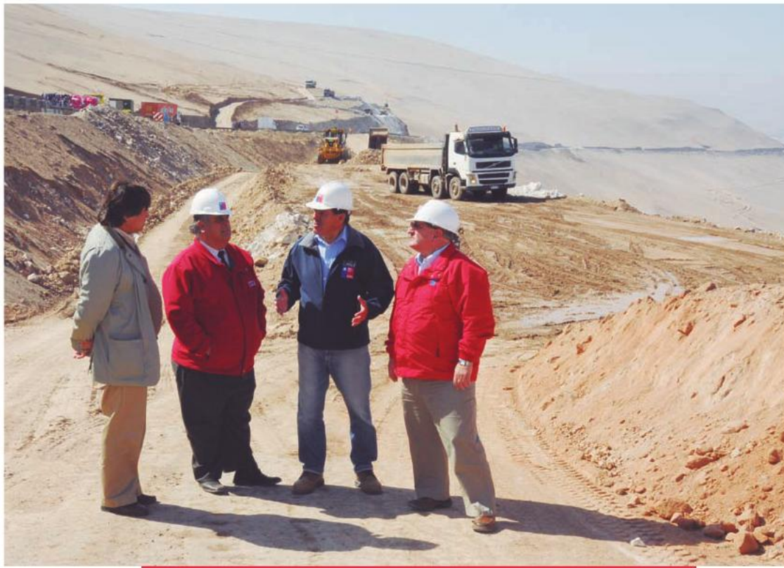
El gobernador de Arica, Patricio López junto al intendente José Durana, visitaron las obras que actualmente ejecuta el MOP en la Cuesta Chaca Norte. 25 de agosto de 2011.
