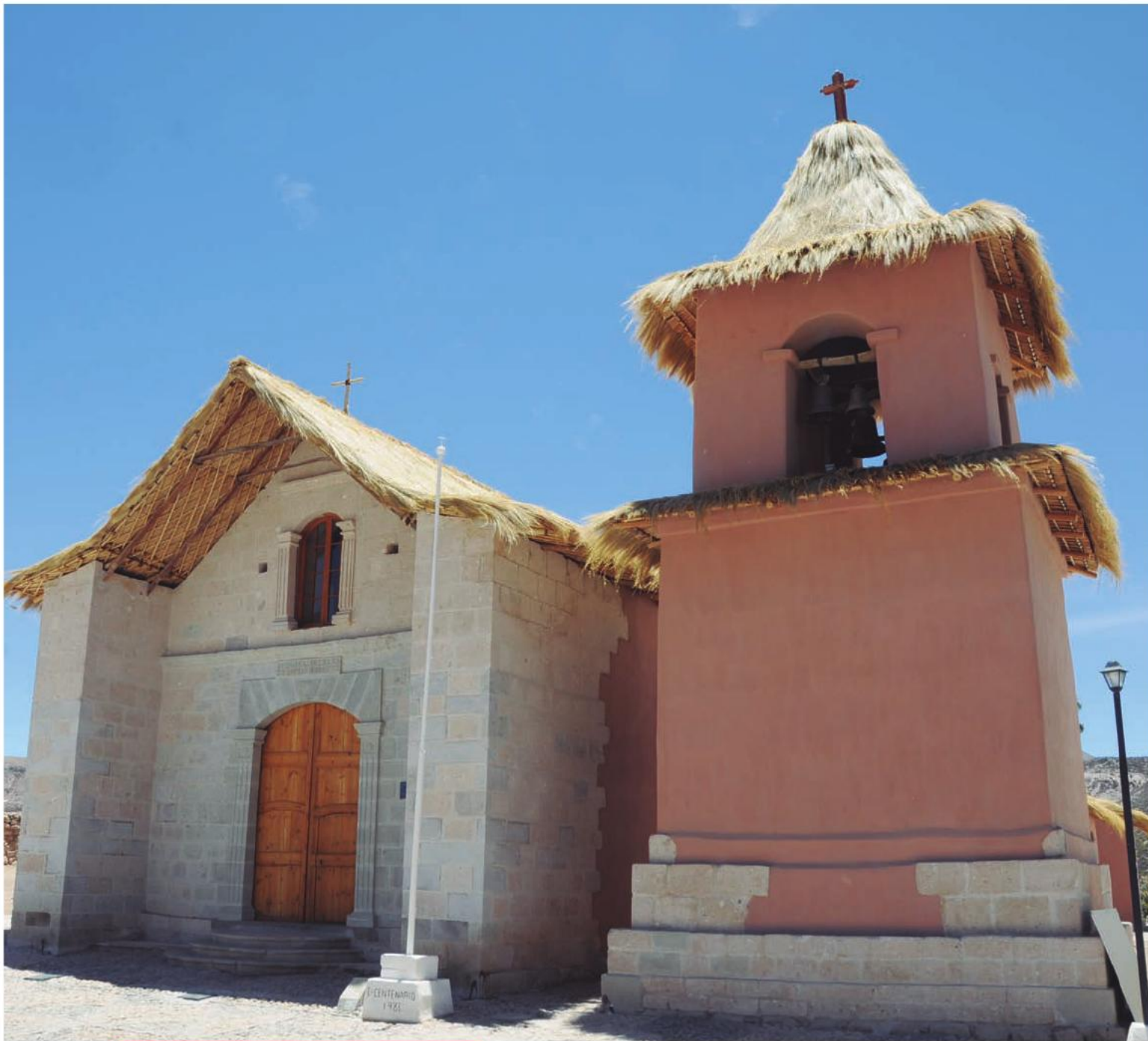
Iglesia de Socoroma, luego de su restauración.
