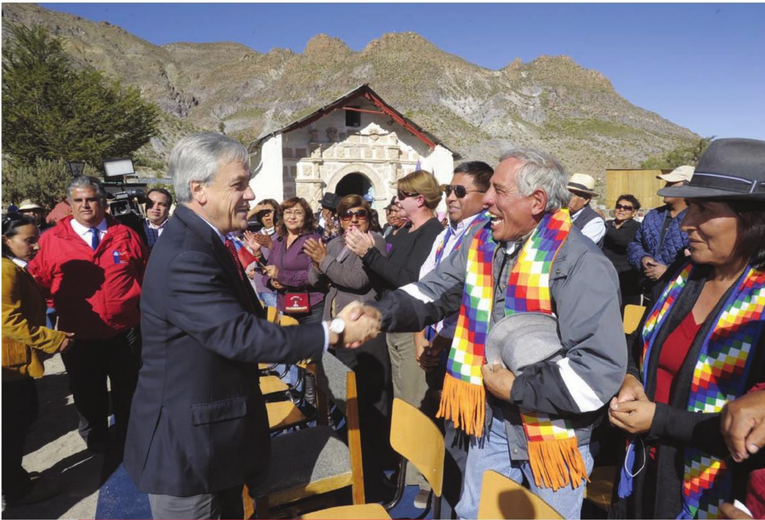
El Presidente Sebastián Piñera, visitando las obras de restauración de la iglesia de Belén, en la comuna de Putre. 29 de mayo de 2012.
