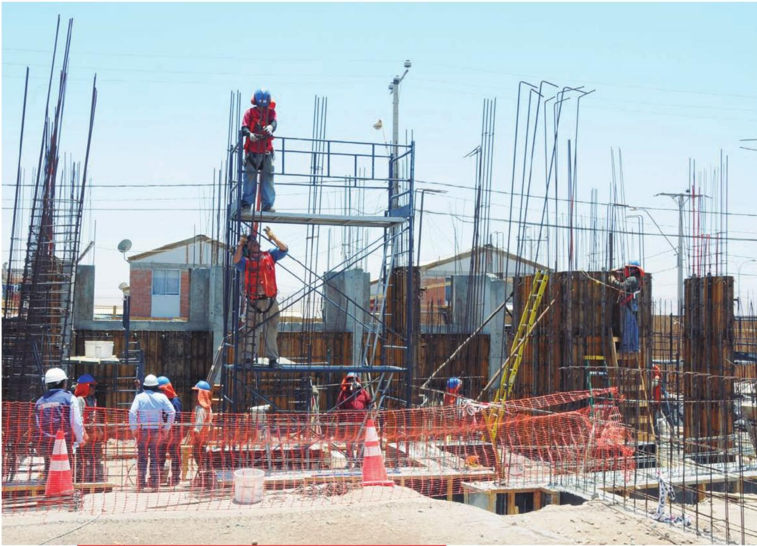
Construcción del futuro laboratorio ambiental del sector El Alto, de Arica.
