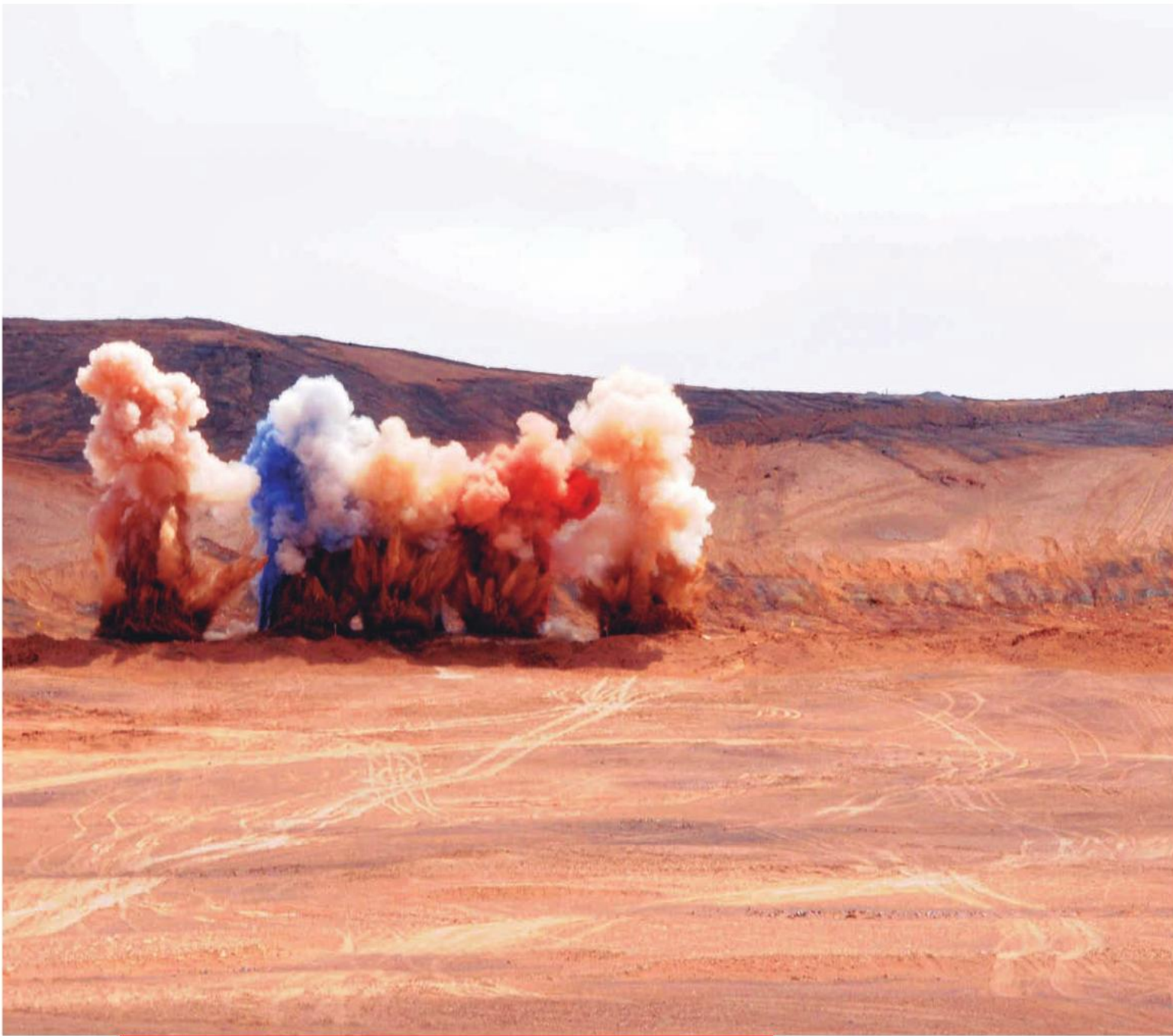
Primera tronadura del proyecto minero Pampa Camarones. 2 de septiembre de 2012.
